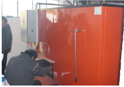
19. Ábra: Biomassza-tüzelésű kazán (Forrás: www.lialokod.ro )
