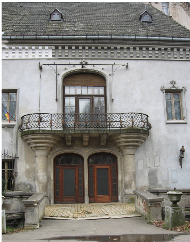
13. kép – Az észak-nyugati homlokzat (fenn)
